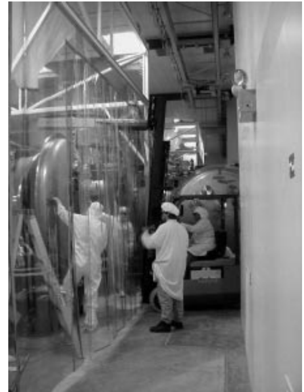
HAM Door Removal (Hanford 4km)
