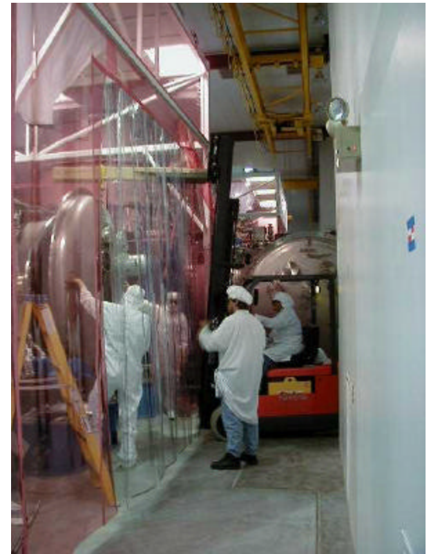
HAM Door Removal (Hanford 4km)
