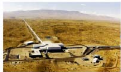
LIGO Hanford WA (4km & 2km)
